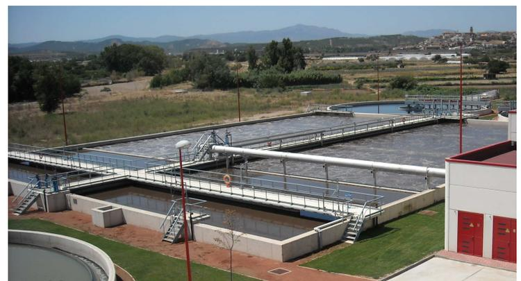
Desde el reactor el agua pasa a dos decantadores secundarios, de 32 m. de diámetro y 4,20 m. de profundidad, donde se separa el agua de la materia en suspensión.
