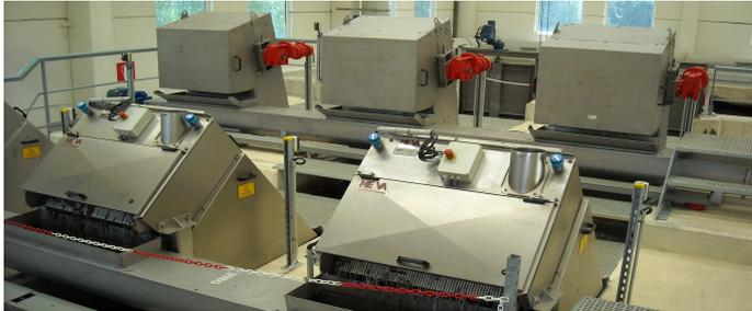
Una vez eliminada la fracción más gruesa, el agua pasa a los desarenadores, tres tanques aireados de 172 m<sup>3</sup> cada uno, donde se retienen las grasas y las arenas que, una vez lavadas y concentradas mediante equipos especiales, se retiran para su eliminación.
