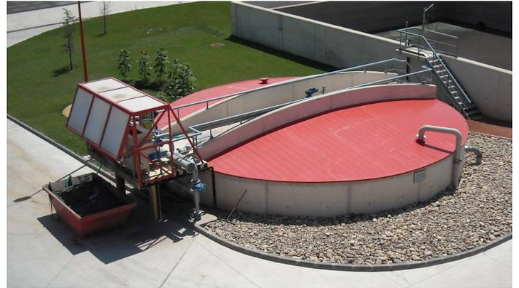
Antes de incorporarlos al tratamiento propiamente dicho los fangos se concentran para reducir su volumen. Los fangos primarios, después de tamizarlos para retirar partículas gruesas, se envían a un espesador estático de 11 m de diámetro y 342 m<sup>3</sup> de capacidad y los fangos secundarios se concentran en dos espesadores dinámicos
