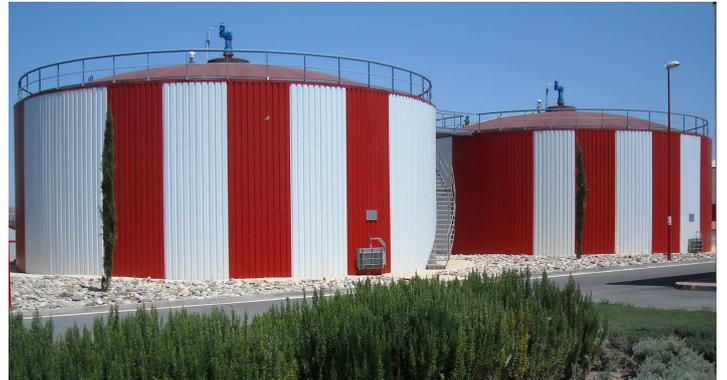
Los fangos digeridos se almacenan en un depósito tampón de 494 m<sup>3</sup>, como paso intermedio al proceso de deshidratación a que es necesario someterlos para conseguir una concentración y una consistencia que faciliten su manipulación.
