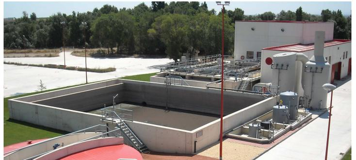
Del pretratamiento, el agua pasa a dos decantadores primarios, de 24 m de diámetro y 3 m de profundidad en vertedero, donde se retiene, en forma de fango primario, una buena parte de la materia en suspensión en el agua. Esa materia, depositada en el fondo de los decantadores, se extrae mediante bombas y se incorpora a la línea de tratamiento de fangos.
