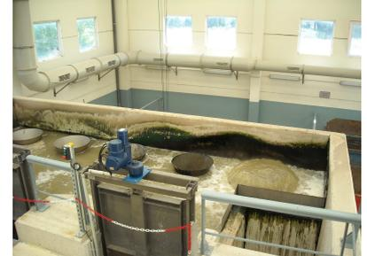
En el pretratamiento se retiran en primer lugar los sólidos de mayor tamaño que transporta el agua haciéndola pasar a través de tres rejillas automáticas de 20 mm de paso y, a continuación, por tres tamices de 3 mm de luz montados en sendos canales paralelos. Los sólidos retenidos en esta etapa se recogen en un tornillo transportador que los compacta y los deposita en contenedores para ser eliminados en vertedero.
