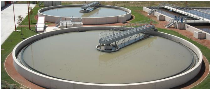
En una segunda fase del proceso, mediante la concurrencia de microorganismos (proceso biológico), la materia orgánica presente en el agua es transformada en materia en suspensión, para poder retenerla por decantación.
