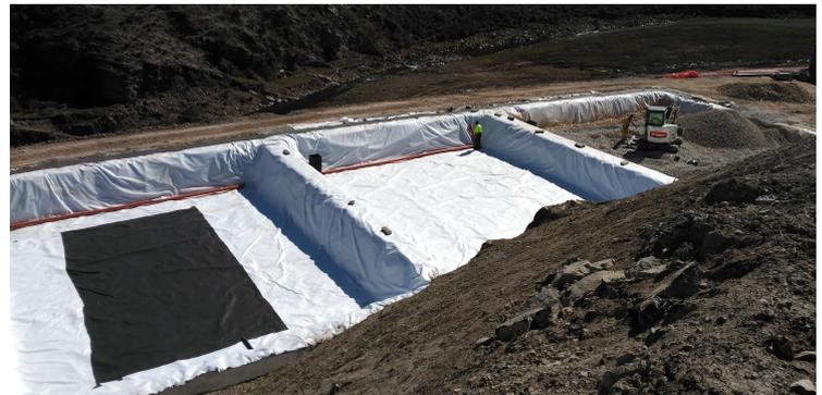
El reparto a cada celda se realiza en la zona de alimentación mediante una canaleta vertedero rodeada de grava 40/80. La recogida del efluente se realiza mediante una tubería de PVC ranurada situada en el lecho de cada vaso, dispuesta también en una zona de drenaje de grava 40/80 que finaliza en una arqueta de polietileno.
