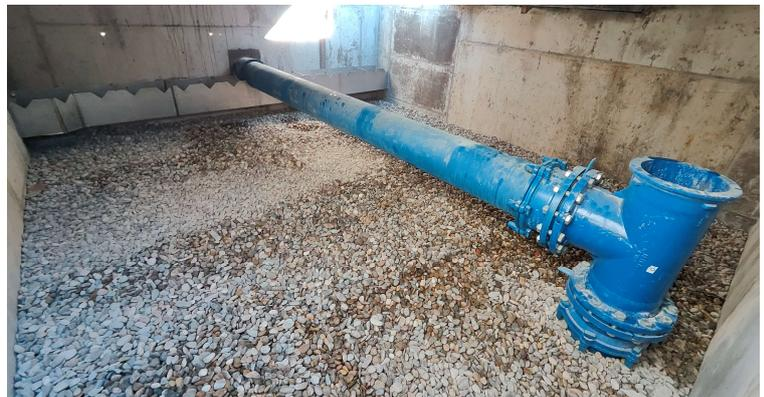
El bombeo que recoge las aguas de la vertiente este, se encuentra ubicado en el paraje de "La Hoya" consta de dos pozos prefabricados de hormigón, de sección circular de 1200 mm de diámetro interior, que están comunicados.
