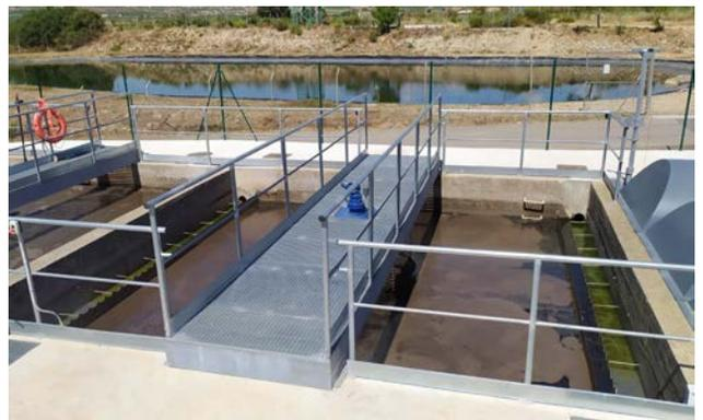
Desde el decantador, el agua entra en un proceso de afino aprovechando la antigua instalación de lagunaje, así el agua se conduce hasta la laguna facultativa preexistente, donde se estima un tiempo de retención de 15 días, y de allí pasa a un nuevo humedal de flujo subsuperficial de 608 m<sup>2</sup>, plantado con *Pragmites australis*, donde se mejora la calidad del vertido.
