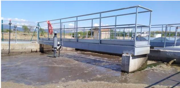
Desde el reactor, el agua pasa al decantador secundario de 7 m. de lado y 2,20 m. de profundidad en vertedero. En él se separa el agua de la materia en suspensión.
