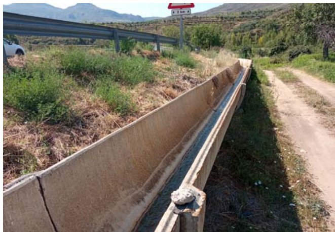
Acequia prefabricada (tramo P15-P16)
