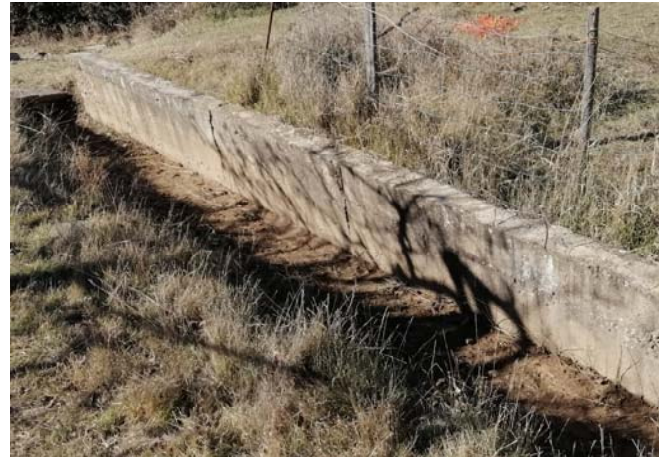
Acequia en hormigón (tramo P6-P7)
