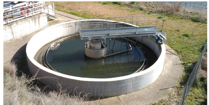
Desde los reactores el agua pasa al decantador de 9 m. de diámetro y 3,00 m. de altura en vertedero. En él se separa el agua de la materia en suspensión, vertiéndose el agua tratada directamente al cauce receptor.
