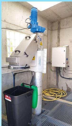
En el edificio del bombeo se aloja también el cuadro eléctrico y la instrumentación que permiten el manejo y control de la instalación, disponiendo de envío de alarmas y de un registro de datos históricos de funcionamiento.
