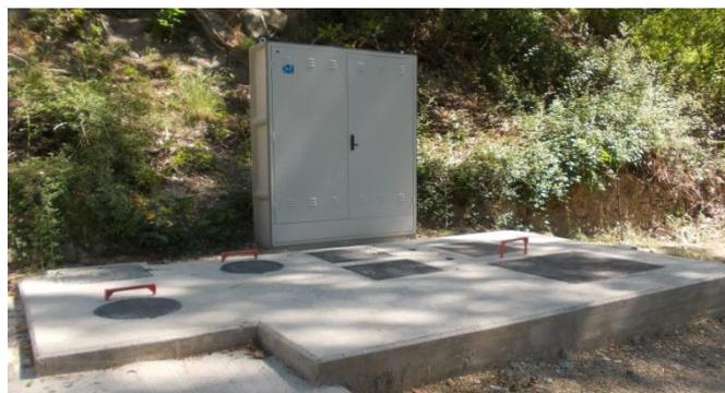
En la arqueta de salida de la fosa séptica se ha previsto otro by-pass para los caudales que excedan del caudal de diseño o poder derivar los caudales tratados en este elemento en aquellos casos que no esté operativo el humedal.
