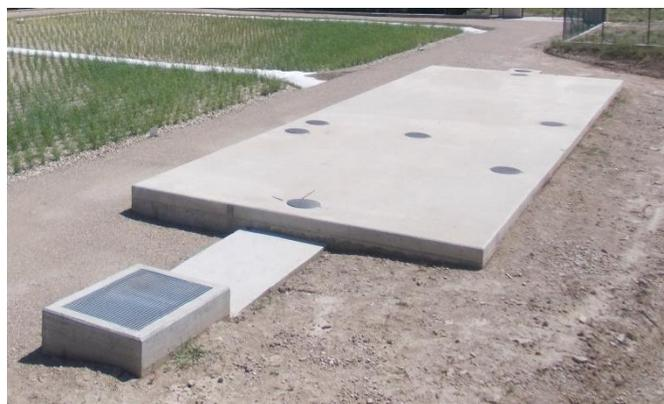
El reparto a cada celda se realiza en la zona de alimentación mediante una canaleta vertedero rodeada de grava 40/80. La recogida del efluente se realiza mediante una tubería de PVC ranurada situada en el lecho de cada vaso, dispuesta también en una zona de drenaje de grava 40/80 que finaliza en una arqueta de polipropileno.
