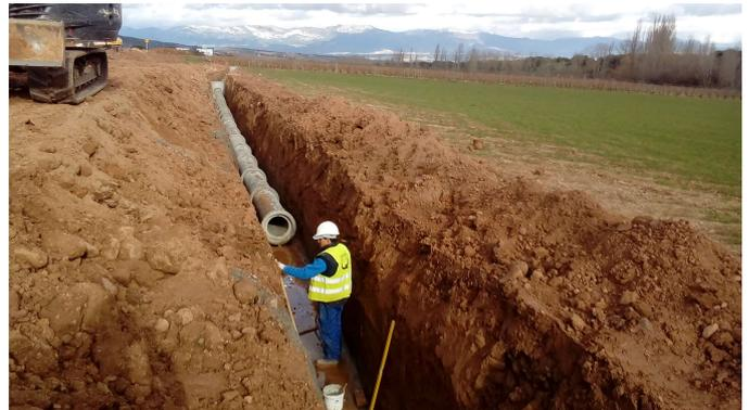
La conducción se dispone enterrada en zanja. Las tuberías se instalan sobre una cama de hormigón y se refuerzan en su parte inferior con el mismo material. El relleno del resto de la zanja se realiza con material procedente de la propia excavación.
