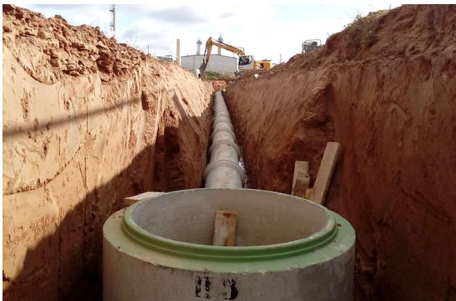
Estos pozos están contruidos con piezas prefabricadas de hormigón de sección circular de 1,20 m de diámetro interior. Sobre una presolera de hormigón se coloca la base prefabricada de hormigón armado que se suministra perforada con las acometidas previstas en cada caso. Sobre esta base se apoyan los anillos prefabricados de hormigón en masa, que irán rematados con una losa o con una pieza troncocónica con una abertura superior circular de 60 cm de paso libre, rematado con la tapa de registro.
