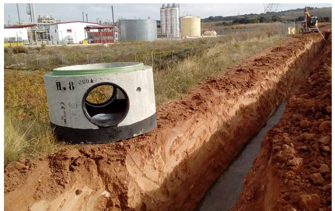
Los marcos y tapas de los pozos de registro son de fundición dúctil de clase D400 conforme a la norma UNE EN-124, siendo articuladas y con paso libre de 60 cm. Los pates a instalar en el interior de los pozos son de polipropileno de alta resistencia con alma de acero. Se colocan con una distancia máxima entre ellos de 33 cm.
