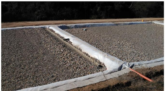
El reparto a cada celda se realiza en la zona de alimentación mediante una canaleta vertedero rodeada de grava 40/80. La recogida del efluente se realiza mediante una tubería de PVC ranurada situada en el lecho de cada vaso, dispuesta también en una zona de drenaje de grava 40/80 que finaliza en una arqueta de polipropileno.
