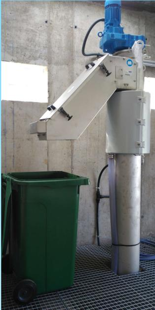
El pozo de bombeo se aloja en una pequeña edificación de 4,30x3,70 m. aguas abajo del núcleo de Bobadilla. El agua residual pasa a través de un tamiz vertical de 3 mm de malla para eliminar los sólidos gruesos, que son prensados y depositados en un contenedor desde el que se retiran periódicamente a vertedero.
