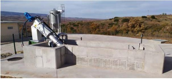
Eliminada la fracción más gruesa, el agua pasa al decantador primario, de 5 m de lado y 2,80 m de profundidad. En él, por acción de la gravedad, se elimina aproximadamente un 60 % de la materia en suspensión y un 30 % del total de materia orgánica. El agua decantada pasa, también por gravedad, al lecho bacteriano.
