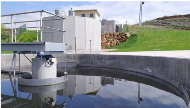
La depuradora está automatizada, de forma que los procesos se regulan para adaptar en cada momento el funcionamiento de la planta a las necesidades reales de tratamiento. Así, está regulado automáticamente el funcionamiento del tamiz, las bombas, la recirculación y purga de fangos y el aporte de agua al lecho, incorporando además un sistema de alarmas para detectar los posibles fallos de funcionamiento de los equipos.
