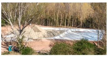
El reparto a cada celda se realiza en la zona de alimentación mediante una canaleta vertedero rodeada de grava 40/80. La recogida del efluente se realiza mediante una tubería de PVC ranurada situada en el lecho de cada vaso, dispuesta también en una zona de drenaje de grava 40/80 que finaliza en una arqueta de hormigón.
