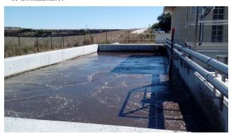
Desde el reactor el agua pasa al decantador secundario, de 7,00 m de lado y 3,40 m de profundidad en vertedero, donde se separan el agua de la materia en suspensión.
