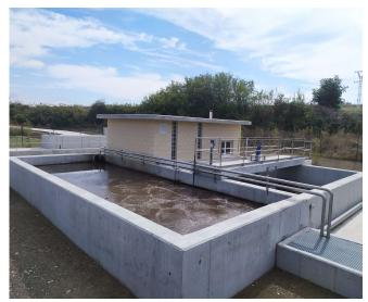
La depuradora está automatizada, de forma que los procesos se regulan para adaptar en cada momento el funcionamiento de la planta a las necesidades reales de tratamiento. Así, está regulado automáticamente el funcionamiento de las bombas, la aireación del reactor, la recirculación de fangos, etc., incorporando además un sistema de transmisión de alarmas para avisar al equipo de mantenimiento de los posibles fallos de funcionamiento de los equipos.
