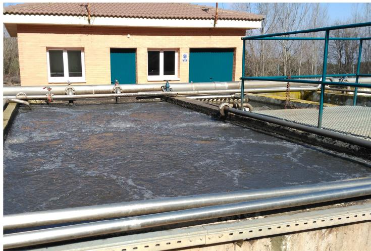
El agua pretratada se conduce a la primera etapa de alta carga, compuesta por un tanque de preaireación con un volumen total de 75,6 m<sup>3</sup>, y un decantador primario de 9 m<sup>2</sup> de planta y 4 m de altura, posteriormente el agua pasa al reactor biológico de segunda etapa, integrado por una cámara anóxica de 36 m<sup>3</sup> de volumen para eliminación de N<sub>2</sub> y el tanque de aireación de 182,4 m<sup>3</sup>.
