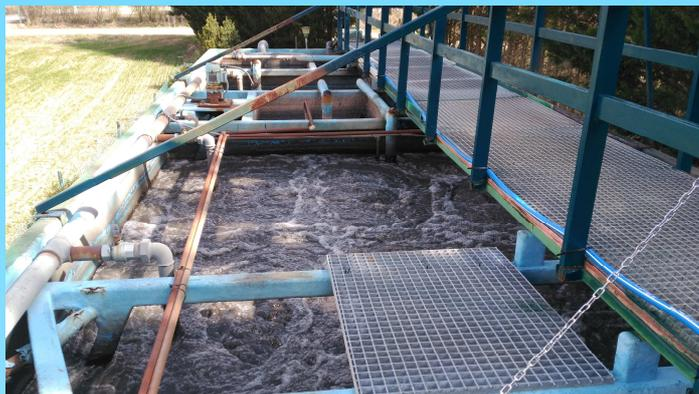
A continuación el agua pasa al tratamiento biológico, donde se consigue la degradación de la materia orgánica a través de un cultivo de microorganismos que se mantiene activo y en suspensión mediante la aportación de aire a través de difusores dispuestos en el fondo de los tanques. En esta instalación, el tratamiento biológico está configurado por una doble etapa, de alta carga la primera y de baja carga la segunda, dispuesta en serie con la anterior.
