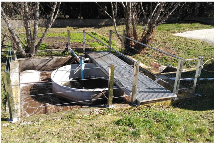
Desde el reactor el agua pasa al decantador secundario, de 2,20 m de diámetro y 3,00 m de profundidad, donde se separa el agua de la materia en suspensión. El agua tratada se vierte directamente al barranco de Los Barros.
