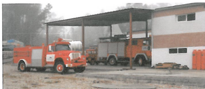
Instalaciones de SEGANOSA
