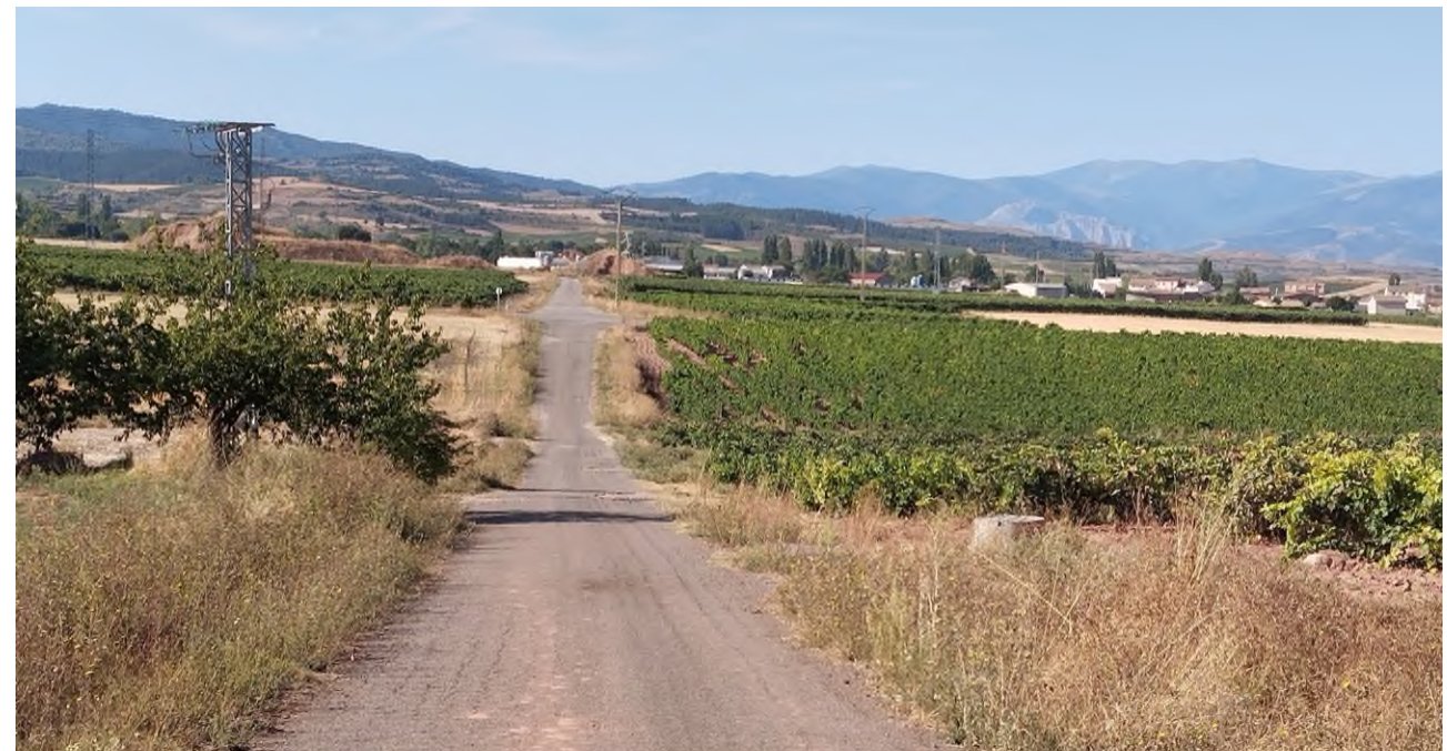
Vista general, al fondo Manjarrés
