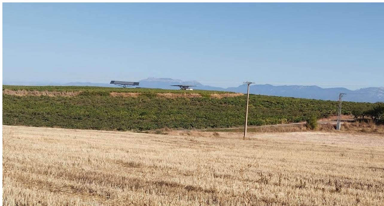
Vista General, línea eléctrica y placas solares en las inmediaciones.
