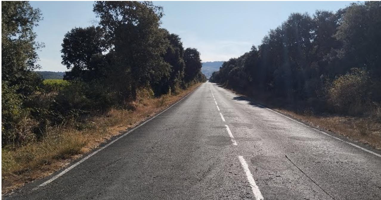
LR-340 (Km 3+700). Vista general de la carretera
