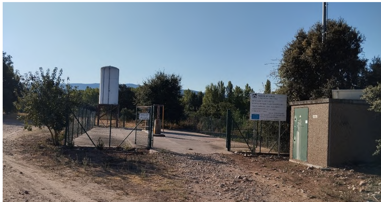
LR-340 (Km 3+500). Instalación de carga de agua junto a la margen derecha de la carretera.
