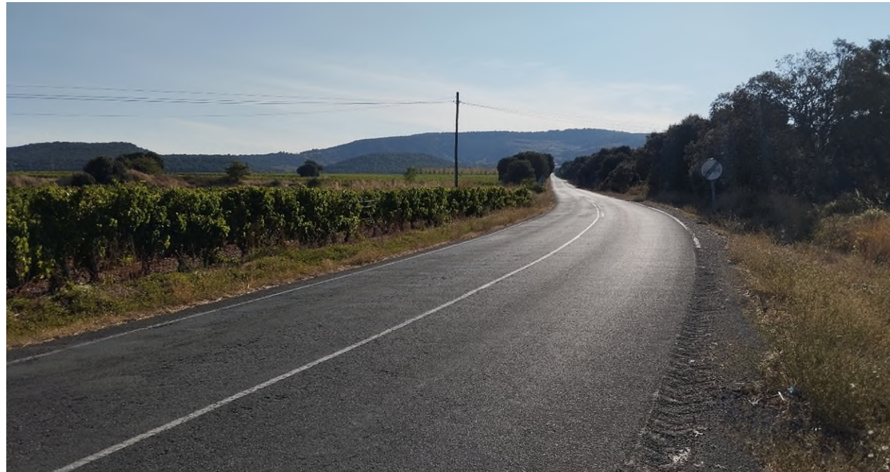
LR-340 (Km 3+500). Viñedo e instalación aérea de servicios.
