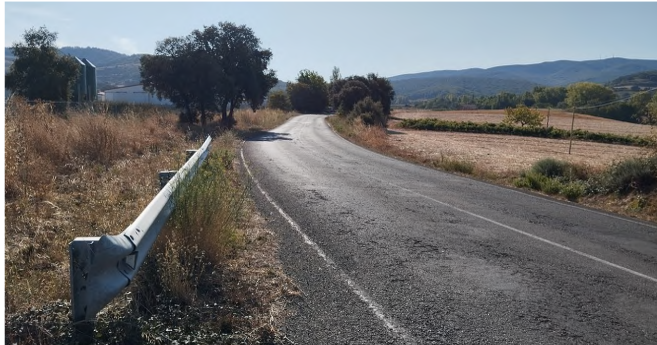
LR-340 (Km 4+700). Vista carretera sentido Santa Coloma.
