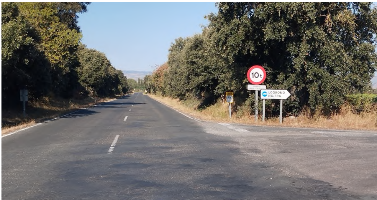
LR-340 (Km 4+000). Desvio para vehículos pesados.
