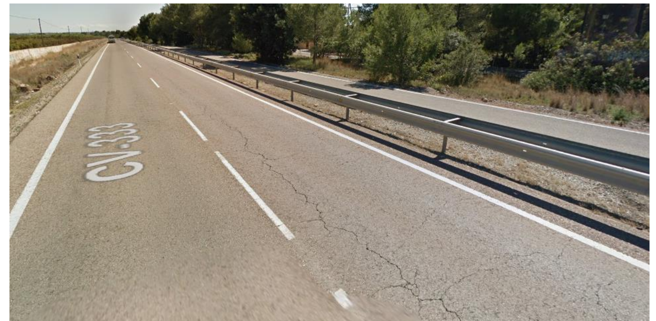
Ilustración 22 – Tramo CV-333 – Separación doble bionda
