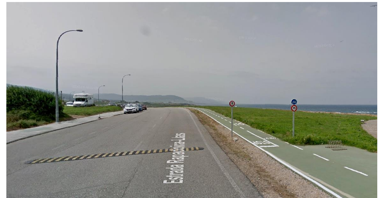
Ilustración 20 – Tramo Estrada Rapadoira Llas – Sin elemento de contención
