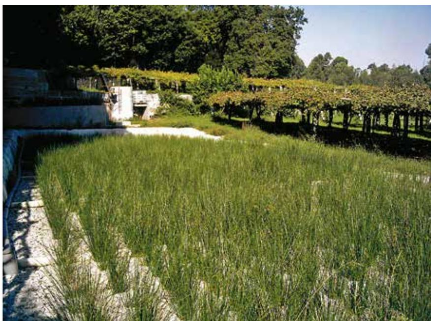
Figura 3. Instalación de depuración de aguas residuales de la bodega Pazo de Señoráns (Meis, Pontevedra), durante la construcción y tras el crecimiento de juncos y carrizos.
