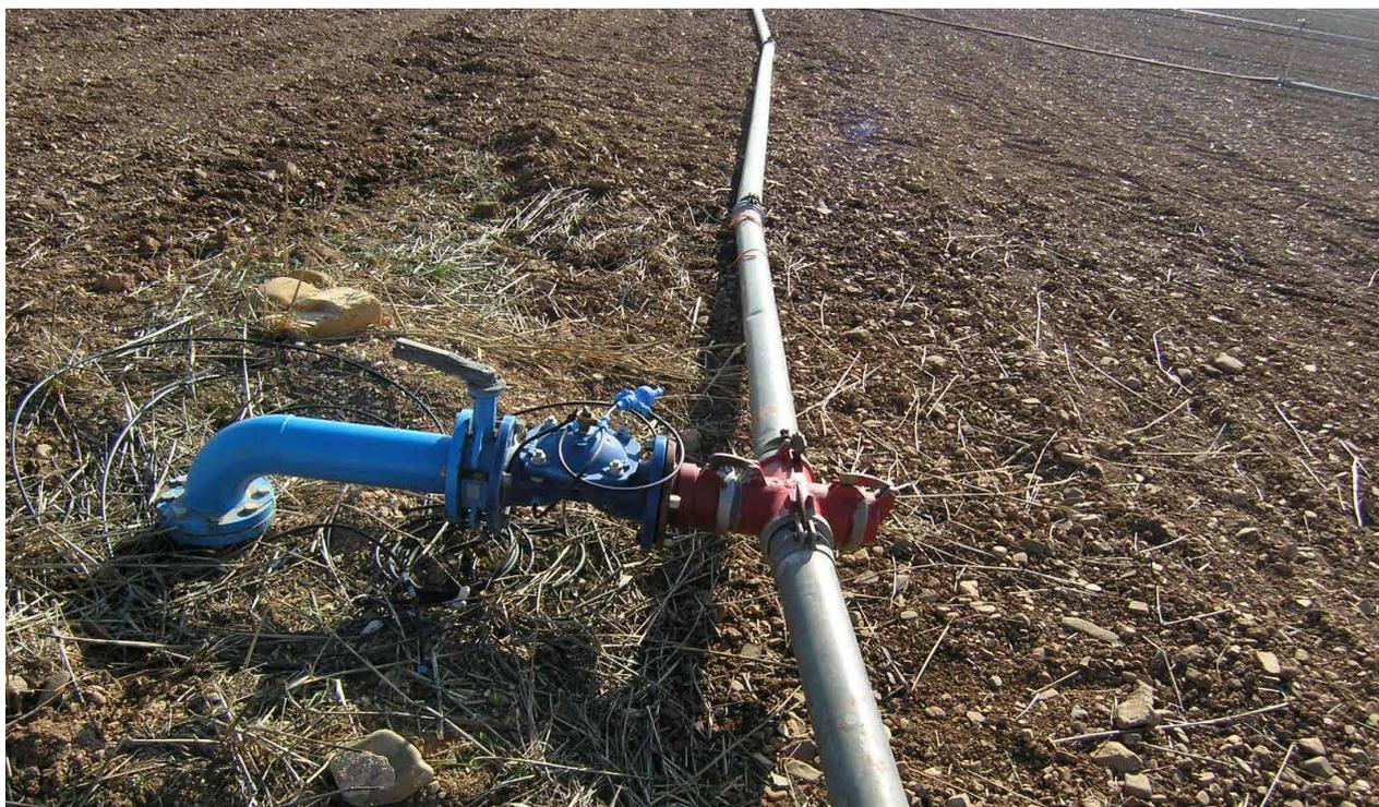
Automatización del riego en una parcela mediante microtubo.
