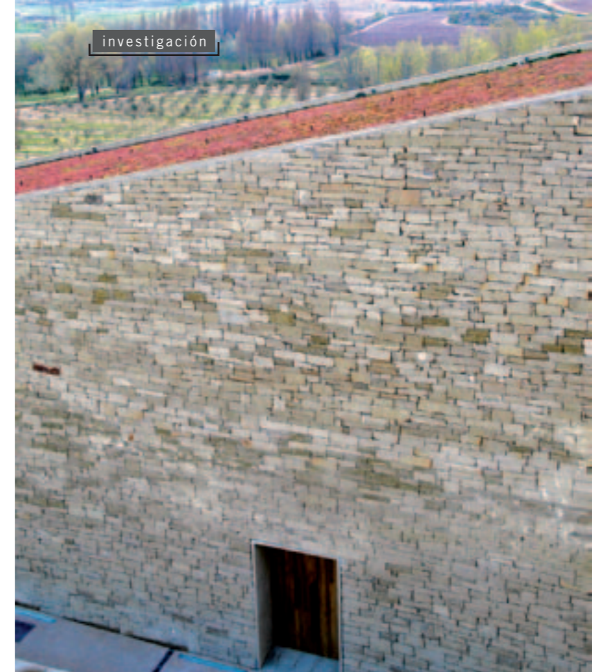
La zona exterior de la bodega está cubierta con un espectacular zócalo de piedra.
