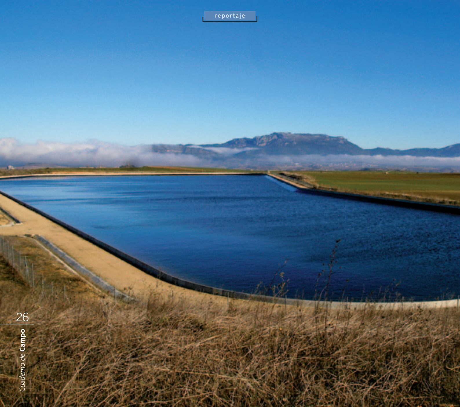
Balsa de Haro, una de las tres que abastecen la red de riego de la zona.
