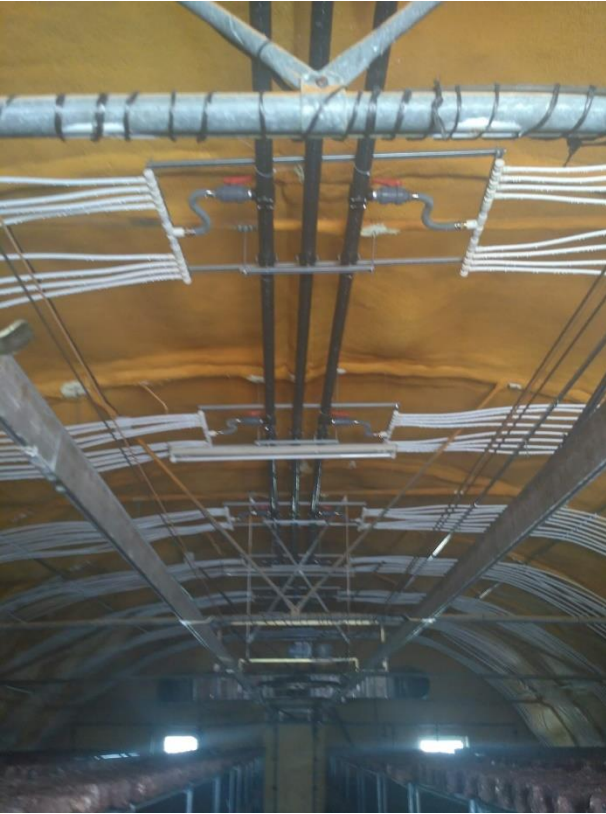
Foto 1. Serpentes de intercambio interior naves I
