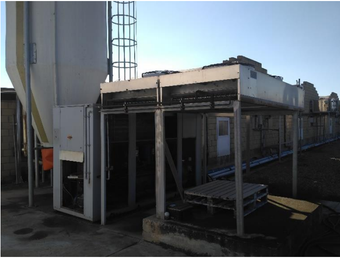
Foto 1. Caldera de biomasa INMECAL CONFORT PLUS
