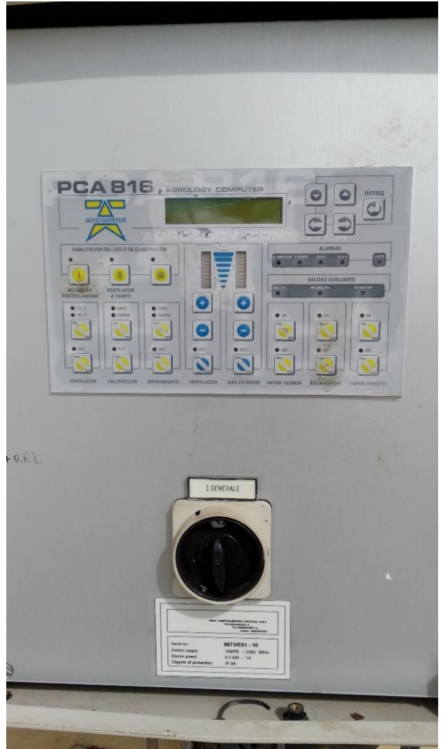
Foto 6. Control Climatizador ACE82B3H
