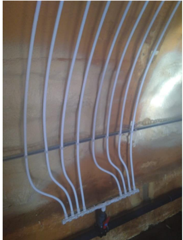
Foto 2. Serpentes de intercambio interior naves II
