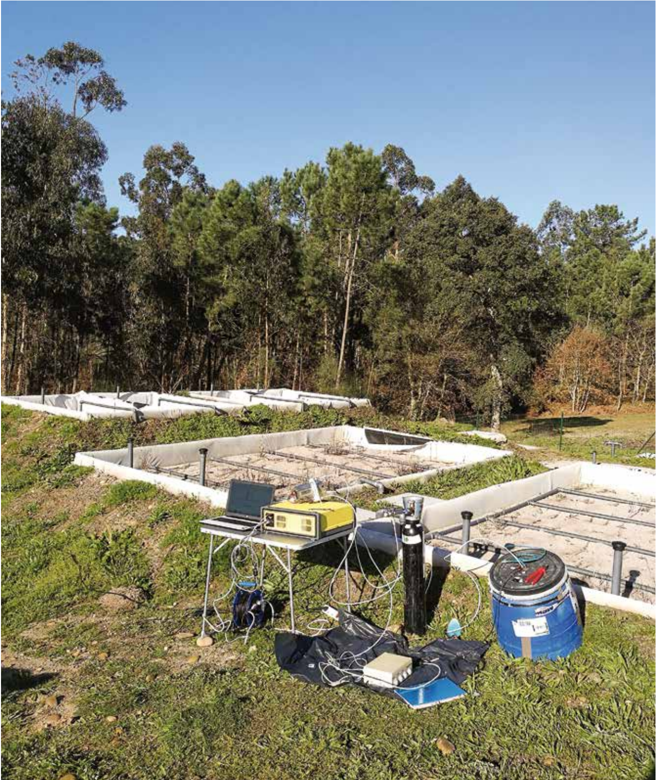
Planta piloto WETWINE. Montaje de los equipos para la medición de gases en un humedal vertical (HV). Vista general de la planta piloto.
