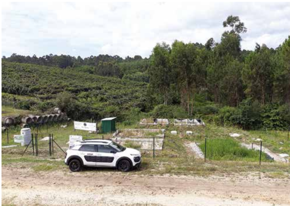
Figura 3. Vista general de la planta WETWINE.
