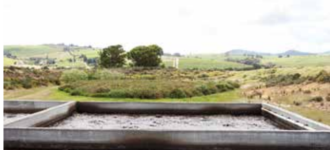
Figure 9. Exemple de traitement de finition par lit planté de roseaux après un premier étage aérobie à la Cave Spier en Afrique du Sud (Muldizi et al. , 2009).
