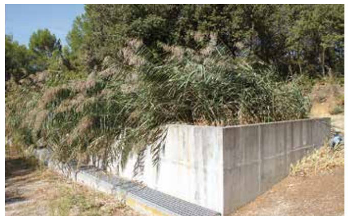
Figure 5. Exemple de traitement des boues par un dispositif de lits plantés dotés de système d'aération naturelle par le dispositif Sint au Château Mont Redon à Châteauneuf-du-Pape.
