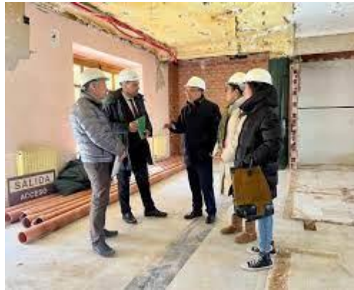
Visita obras PEF, Haro, 6 de febrero 2022
