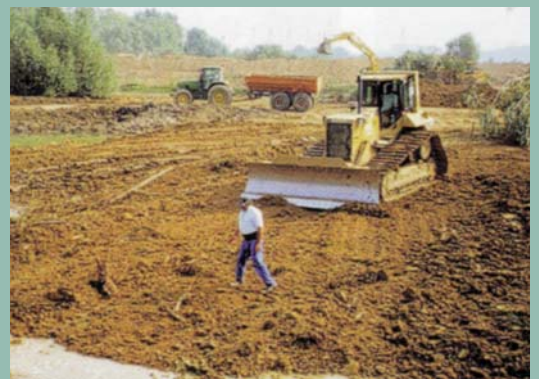
Trabajos de preparación del suelo
