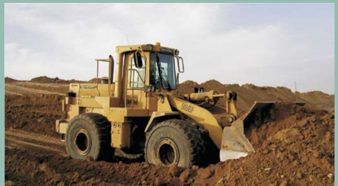
Retirada de la cubierta con bulldozer y pala cargadora
