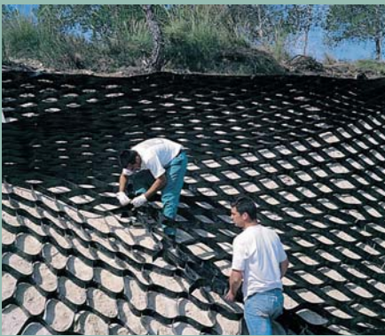
Colocación de Geotextil (foto: Projar, S.A.)
