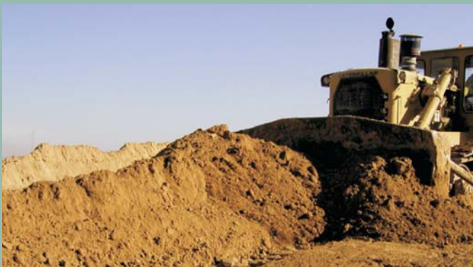
Retirada de la cubierta con bulldozer y pala cargadora
