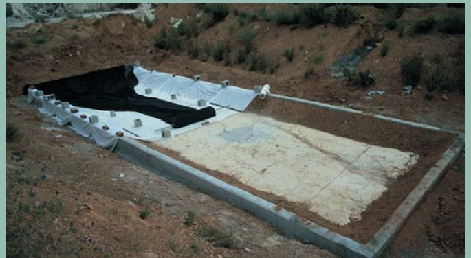
Acondicionamiento del hueco (foto: J. C. Monzó)
