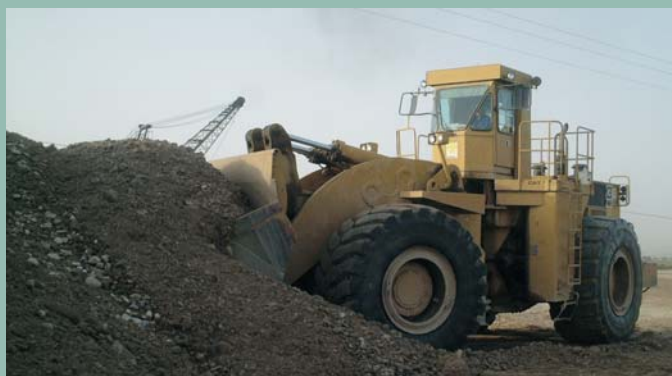
Manipulación de materiales de relleno con pala cargadora
