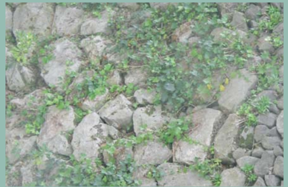
Refuerzo de talud con escollera y revegetación
