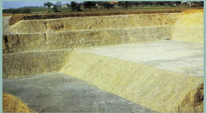
Relleno del hueco
