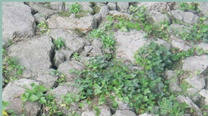
Reforzamiento con escollera
