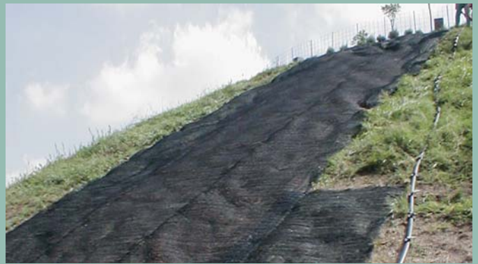
Malla volumétrica instalada como soporte de la tierra vegetal (foto: Projar, S.A.)
