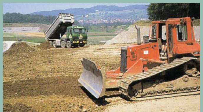
Trabajos de retirada del suelo
