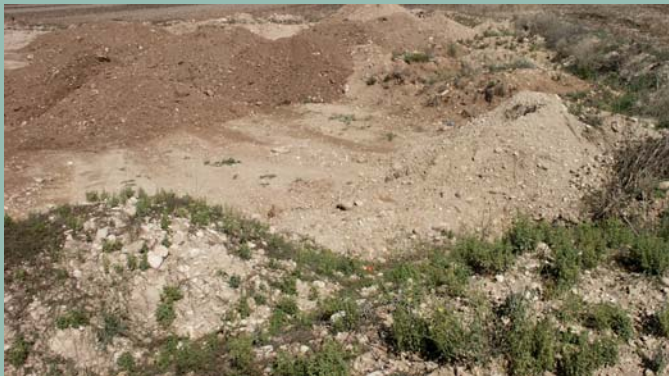
Relleno del hueco con estériles inertes adecuados
