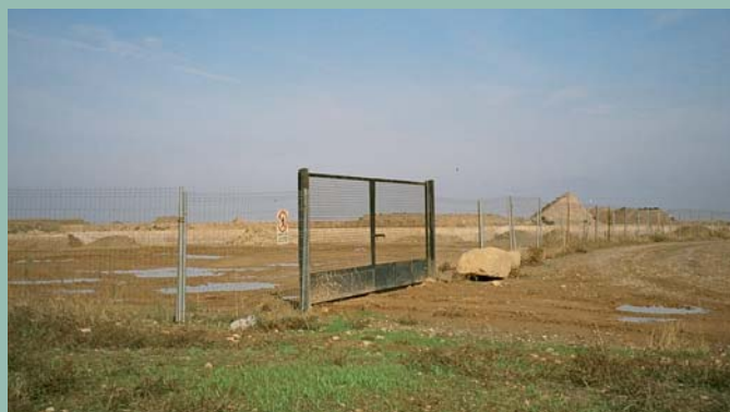
Vallado y señalización de la prohibición del acceso
