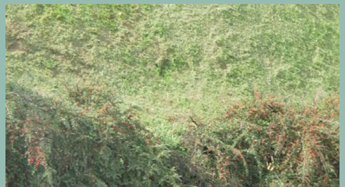
Protección de la superficie de talud por siembra
