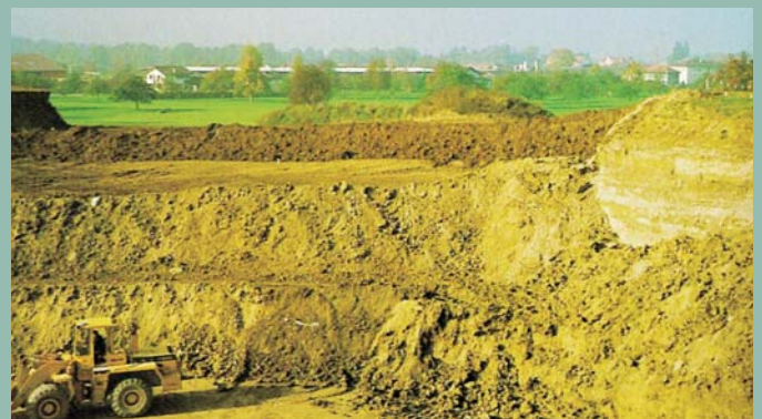
Cordón de tierra vegetal en la parte superior
