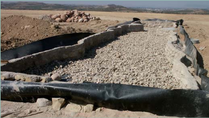
Acondicionamiento del hueco
