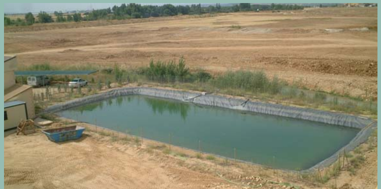
Balsa de aguas limpias con solera de geotextil
