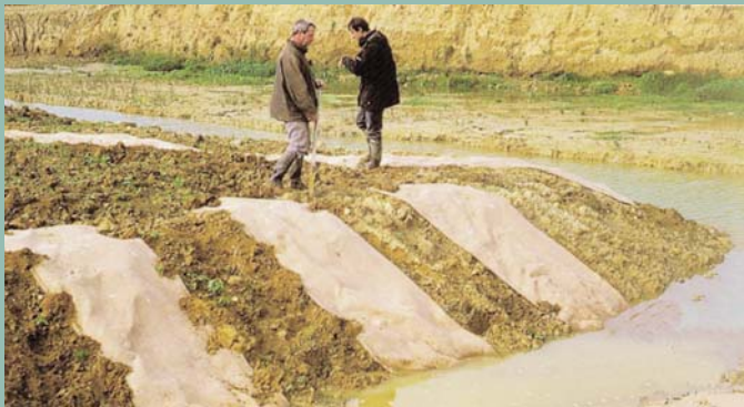
Empleo de geotextiles
