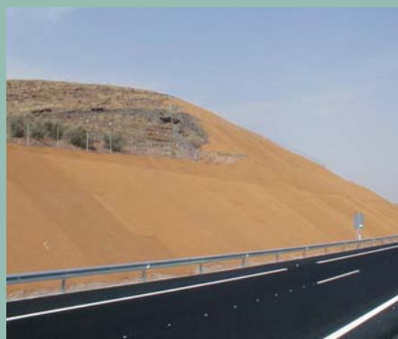
Talud recubierto con manta orgánica (foto: Projar, S.A.)
