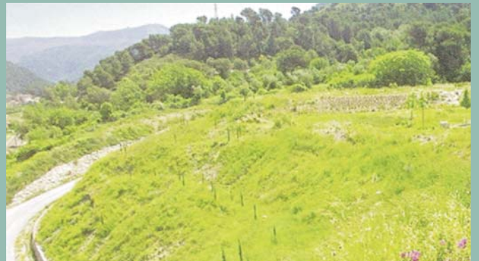
Primer plano del talud repoblado
