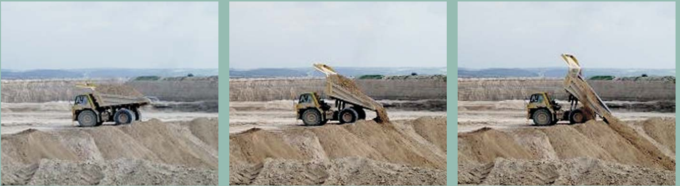
Operación de vertido para relleno del hueco
