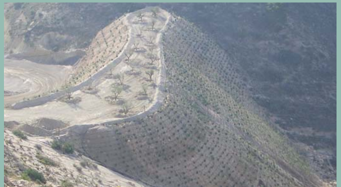
Vista general de un talud restaurado
