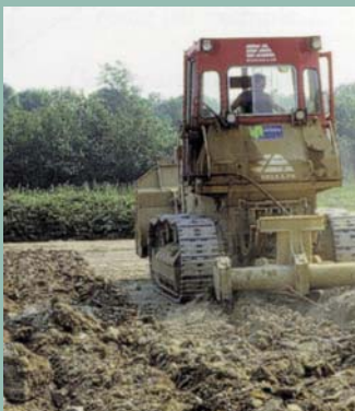
Trabajos de descompactación: escarificado y preparación superficial
