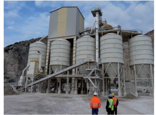
*Planta de hormigón, compuesta de silos para cemento, aditivos, áridos y mezcladora*
