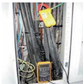
Pinzas amperimétricas conectadas a polímetro
