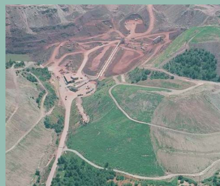
Restauración de escombreras mediante bulldozer con pendientes de 25°, extendido de tierra vegetal e hidrosiembra. Posteriormente, plantación de árboles de 1-2 savias y reubicación de antiguos olivos procedentes de otras zonas de la explotación (13)
