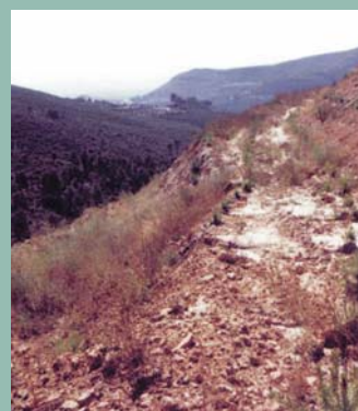
Restauración de escombrera: desdoblamiento en bancos, saneo del cauce del barranco con construcción de un muro de contención de escollera, extendido de tierra vegetal, instalación de riego por goteo, siembra de gramíneas y leguminosas a voleo (esparceta y alfalfa), plantación de 4.500 pinos carrascos de una savia (14)
