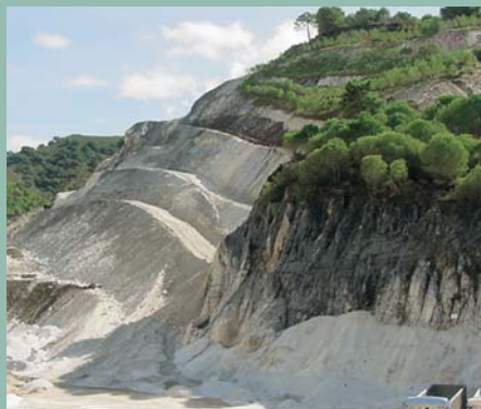
Restauración paisajística en un paraje natural. Remodelación de un frente de cantera abandonado de gran altura e inestabilidad en un talud tendido e integrado en el paisaje. Aporte de grandes volúmenes de tierra vegetal y una plantación de 5.700 pinos de 2,5 m, especie predominante en la zona (10)
