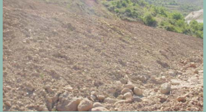
Acondicionamiento del talud
