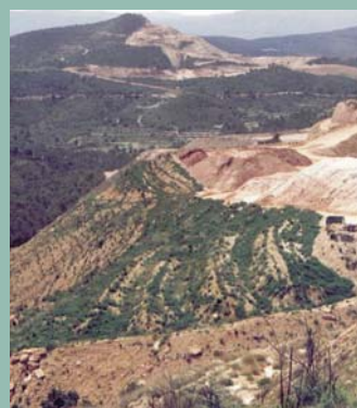
Restauración de escombrera: desdoblamiento en bancos, saneo del cauce del barranco con construcción de un muro de contención de escollera, extendido de tierra vegetal, instalación de riego por goteo, siembra de gramíneas y leguminosas a voleo (esparceta y alfalfa), plantación de 4.500 pinos carrascos de una savia (14)
