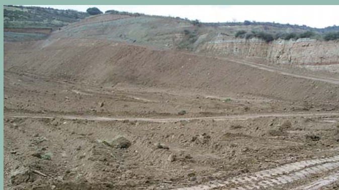
Restauración de taludes y plaza de explotación. Situación intermedia de los trabajos
