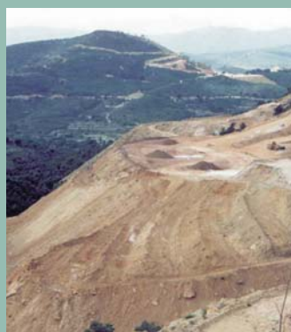
Restauración de escombrera: desdoblamiento en bancos, saneo del cauce del barranco con construcción de un muro de contención de escollera, extendido de tierra vegetal, instalación de riego por goteo, siembra de gramíneas y leguminosas a voleo (esparceta y alfalfa), plantación de 4.500 pinos carrascos de una savia (14)
