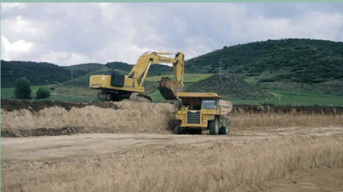
Retirada de las capas superficiales de suelo
