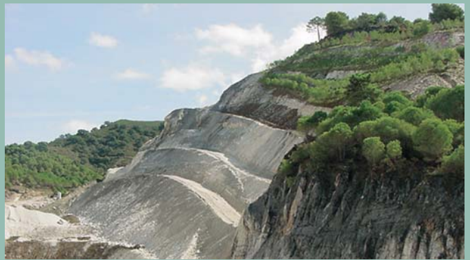
Frete de cantera con los bancos superiores restaurados y revegetados. Los inferiores se encuentran remodelados, a la espera de la plantación
