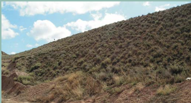
Taludes remodelados y revegetados
