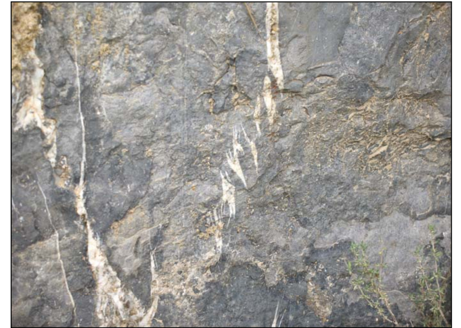
GRIETAS DE EXTENSIÓN DE CERVERA
