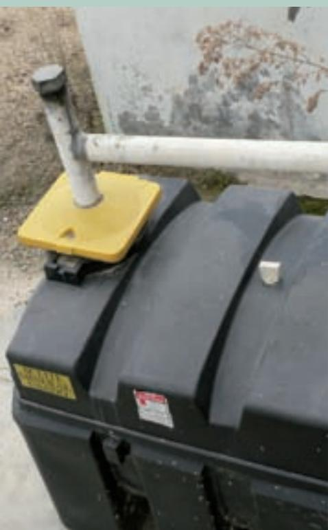
Sistema de recogida y separación de aceites usados
