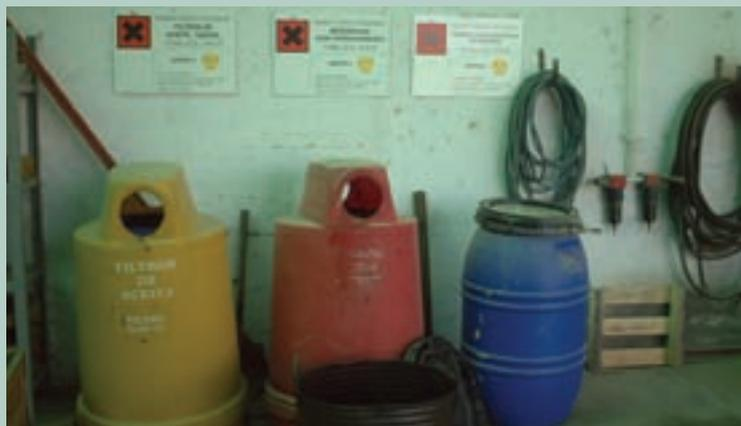
Depósitos para filtros de aceite y para trapos con hidrocarburos, señalizados
