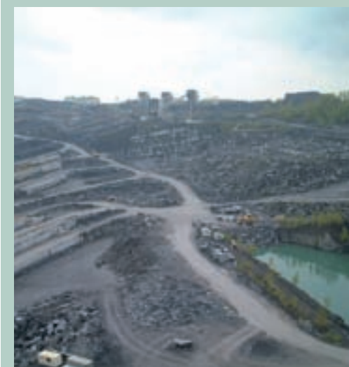
Gestión adecuada de las materias primas. Los residuos de la extracción de roca ornamental son materia prima para áridos
