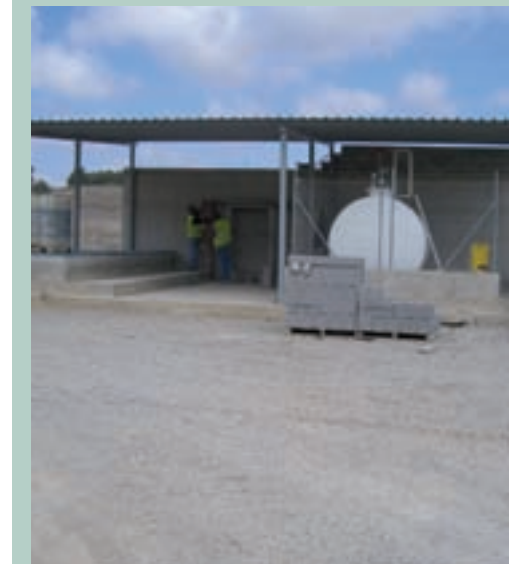
Construcción de una cubeta para derrames de hidrocarburos
