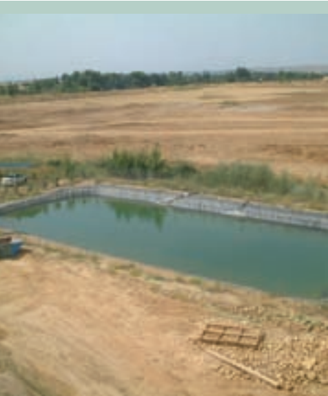
Balsa de aguas limpias con solera de geotextil y vallada
