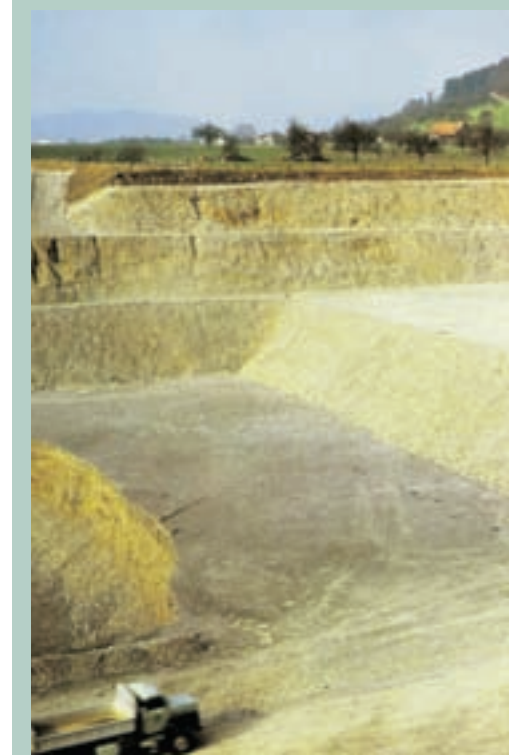
Relleno del hueco de explotación con residuos
