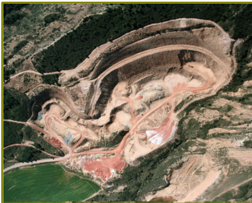
Cantera Sampedro (explotación de arcillas)
