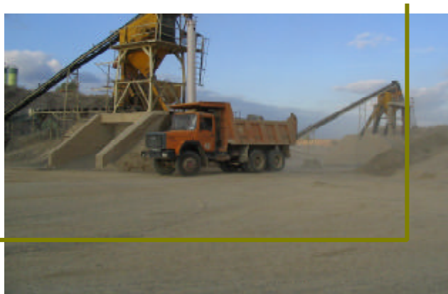
Explotación de áridos "Baños"
