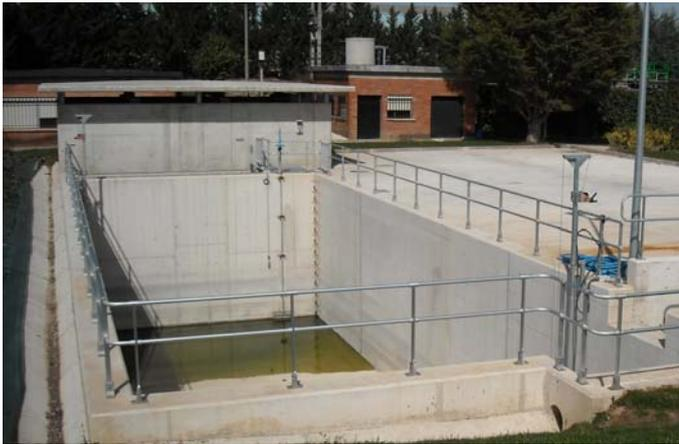
El bombeo consta de un pozo al que llega el agua residual y una cámara seca anexa en la que se disponen cuatro bombas -una de ellas en reserva- de 18,5 kw cada una, provistas de sus correspondientes válvulas de retención y alivio de sobrepresiones.
