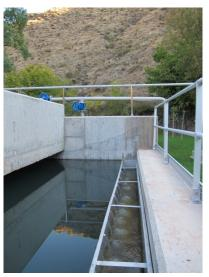
Desde el reactor el agua pasa al decantador secundario, de 5,00 m de lado y 3,50 m de profundidad en vertedero, donde se separa el agua de la materia en suspensión. El agua se incorpora al decantador a través de una campana deflectora, situada en el centro del tanque, que distribuye el flujo uniformemente hacia los canales perimetrales en los que se recoge el efluente clarificado.
