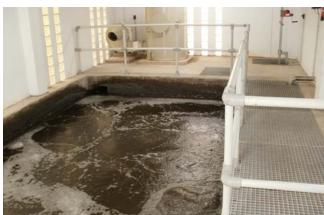
Desde el reactor el agua pasa al decantador secundario, de 5,00 m de lado y 3,75 m de profundidad en vertedero, donde se separan el agua de la materia en suspensión. El agua se incorpora al decantador a través de una campana deflectora, situada en el centro del tanque, que distribuye el flujo uniformemente hacia los dos canales perimetrales en los que se recoge el efluente clarificado.
