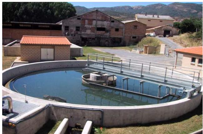
Desde el reactor, el agua pasa al decantador secundario de 13 m. de diámetro y 3,40 m. de profundidad donde se separa el agua de la materia en suspensión.
