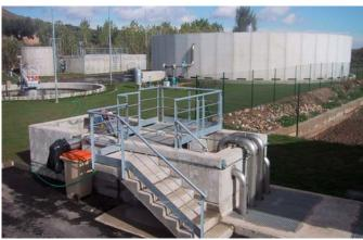
Eliminada la fracción más gruesa, el agua pasa al decantador primario, de 9 m de diametro y 3 m de profundidad, donde se elimina, por acción de la gravedad, aproximadamente un 75% de la materia en suspensión y un 40 % del total de materia orgánica.
