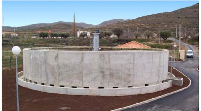
Desde el lecho, el agua pasa al decantador secundario, de 9 m de diámetro y 3 m de profundidad, donde se separa el agua de la materia en suspensión.
