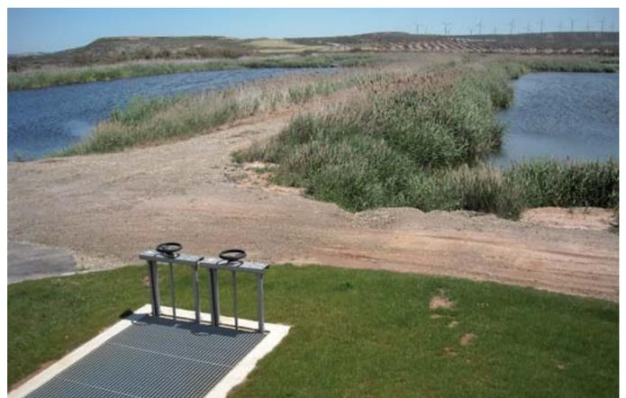
De esta forma la nueva instalación aprovecha las antiguas lagunas construidas en los años 80 como sistema de depuración del municipio y que en la actualidad ya no permitían alcanzar los niveles de calidad en el efluente exigidos por la normativa. La depuradora está automatizada, de forma que los procesos se regulan para adaptar en cada momento el funcionamiento de la planta a las necesidades reales de tratamiento.
