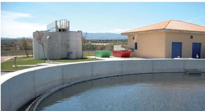
La Estación Depuradora de Aguas Residuales (EDAR) de Pradejón está situada en la margen izquierda del Barranco de las Costeras. Recibe el vertido del municipio a través de un colector de hormigón de 600 mm de diámetro y 948 m de longitud.
