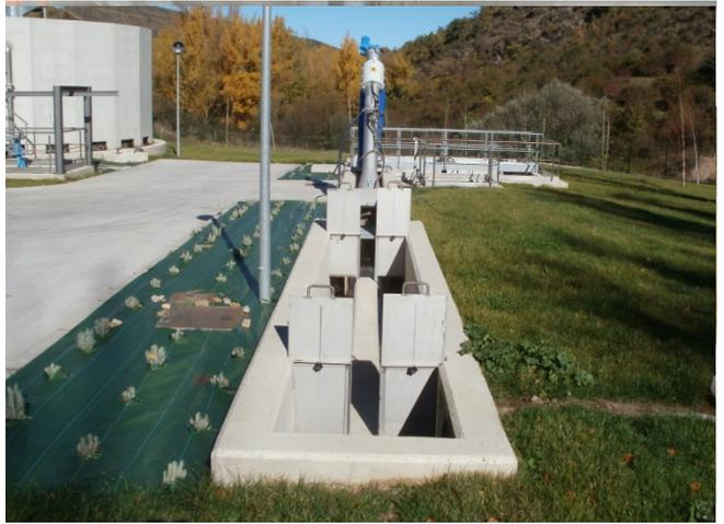
La materia retenida en el tamiz la recoge un tornillo transportador que incorpora el propio tamiz y que la deposita en un contenedor que periódicamente se retira a vertedero.
