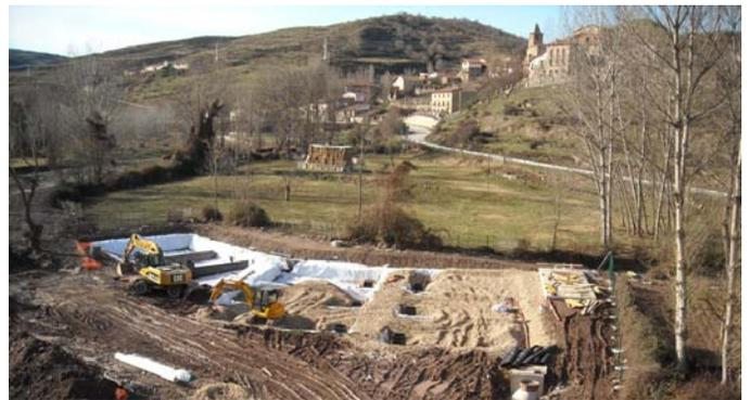
El reparto a cada celda se realiza en la zona de alimentación mediante una tubería de PVC ranurada rodeada de grava 40/80. La recogida del efluente se realiza del mismo modo, mediante otra tubería de PVC ranurada situada en el lecho de cada celda, dispuesta también en una zona de drenaje que finaliza en una arqueta de polipropileno.
