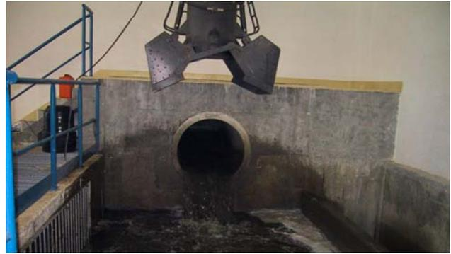
Desde el pozo de gruesos el agua pasa por gravedad a la línea de tratamiento. En primer lugar, en los canales de desbaste se retiene una buena parte de los sólidos en suspensión mediante dos rejillas de gruesos de 30 mm de paso, y dos tamices de 4 mm de luz. Un tercer canal, de las mismas características que los anteriores, está equipado con una rejilla de limpieza manual para funcionar como by-pass en caso de necesidad.
