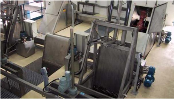
Una vez retenida la fracción más gruesa el agua pasa a dos tanques aireados de 14 m de longitud y 4 m de anchura, donde se retienen las arenas y las grasas que transporta el agua residual. Estas se acondicionan en un clasificador de arenas y en un concentrador de grasas previamente a ser retiradas de la planta.
