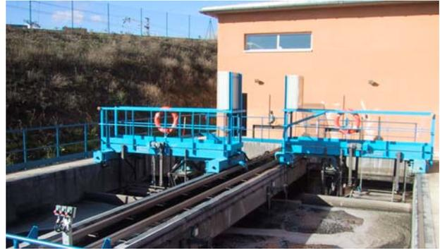
Completado el pretratamiento, el agua residual se incorpora a la segunda fase del proceso donde, mediante la concurrencia de microorganismos (proceso biológico), la materia orgánica presente en el agua se transforma en materia en suspensión que puede ser separada por decantación.
