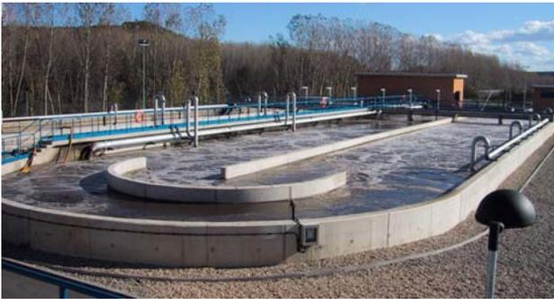
Desde los reactores el agua se reparte a dos decantadores secundarios, de 28 m de diámetro y 3,5 m de profundidad en vertedero, donde se separa el agua de la materia en suspensión.
