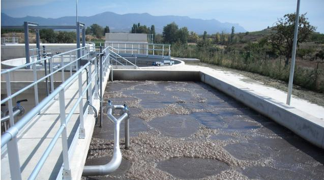
Mediante aportación de aire se mantiene activo en el reactor un cultivo de microorganismos que transforman la materia orgánica presente en el agua en materia en suspensión que puede ser separada posteriormente por decantación. El reactor se mantiene aireado mediante 3 soplantes, de 420 Nm<sup>3</sup>/h de caudal unitario que distribuyen el aire desde el fondo mediante difusores de burbuja fina. Cada reactor dispone de una cámara anóxica para eliminación de nitrógeno.
