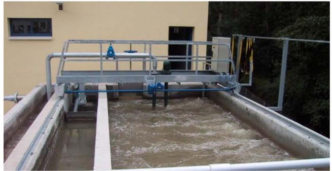
Una vez retenida la fracción más gruesa el agua pasa a un tanque aireado, de 8,00 m de longitud y 3,6 m de anchura, donde se separan las arenas y las grasas, que se concentran antes de ser retiradas de la planta.
