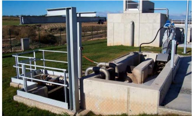
Eliminada la fracción más gruesa, el agua pasa al decantador primario, de 9 m de diámetro y 3 m de profundidad, donde se elimina, por acción de la gravedad, aproximadamente un 40% de la materia en suspensión y un 25 % del total de materia orgánica.
