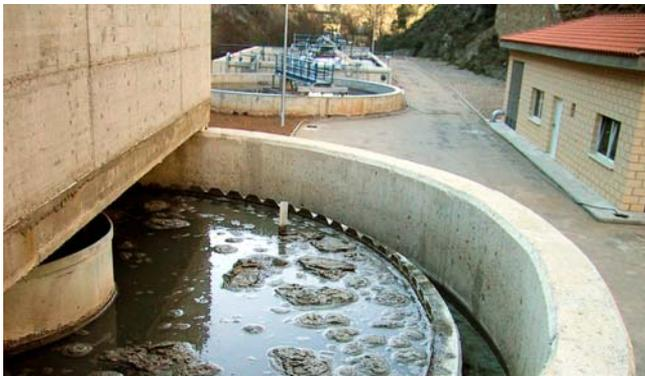
La planta cuenta con una arqueta de recepción de fangos primarios procedentes de otras instalaciones. Estos fangos pasan a través de un tamiz automático de 3 mm. de paso para retirarles las partículas gruesas, y son bombeados al espesador, incorporándose así a la línea de tratamiento de fangos de la depuradora.
