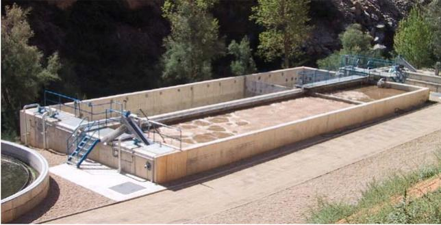
Desde los reactores, el agua pasa al decantador secundario de 12 m. de diámetro y 3.50 m. de profundidad. En él se separa el agua de la materia en suspensión, vertiéndose el agua tratada directamente al río.
